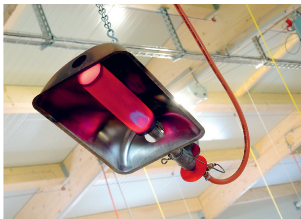
Gasstrahler im Geflügelstall.
