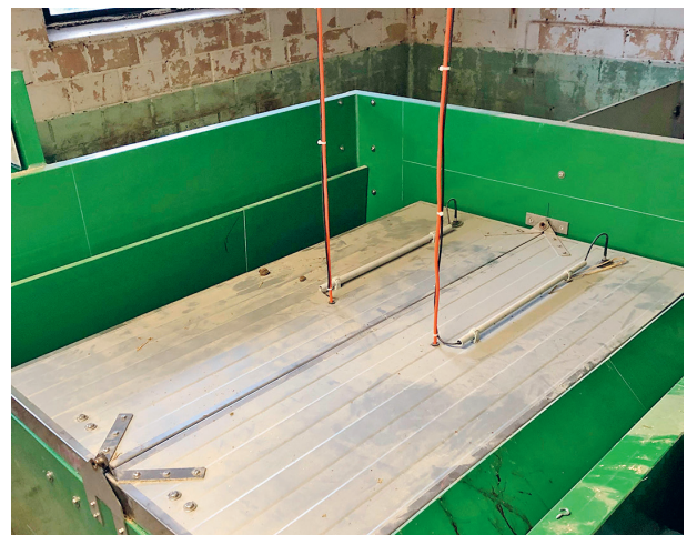
Sicher verlegte Stromkabel über einem Ferkel-nest.
