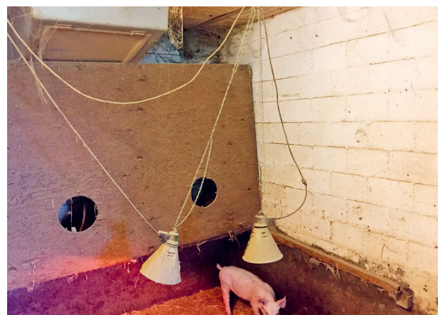
Hier ist die Gefahr für einen Stromschlag oder einen Brand gross.
